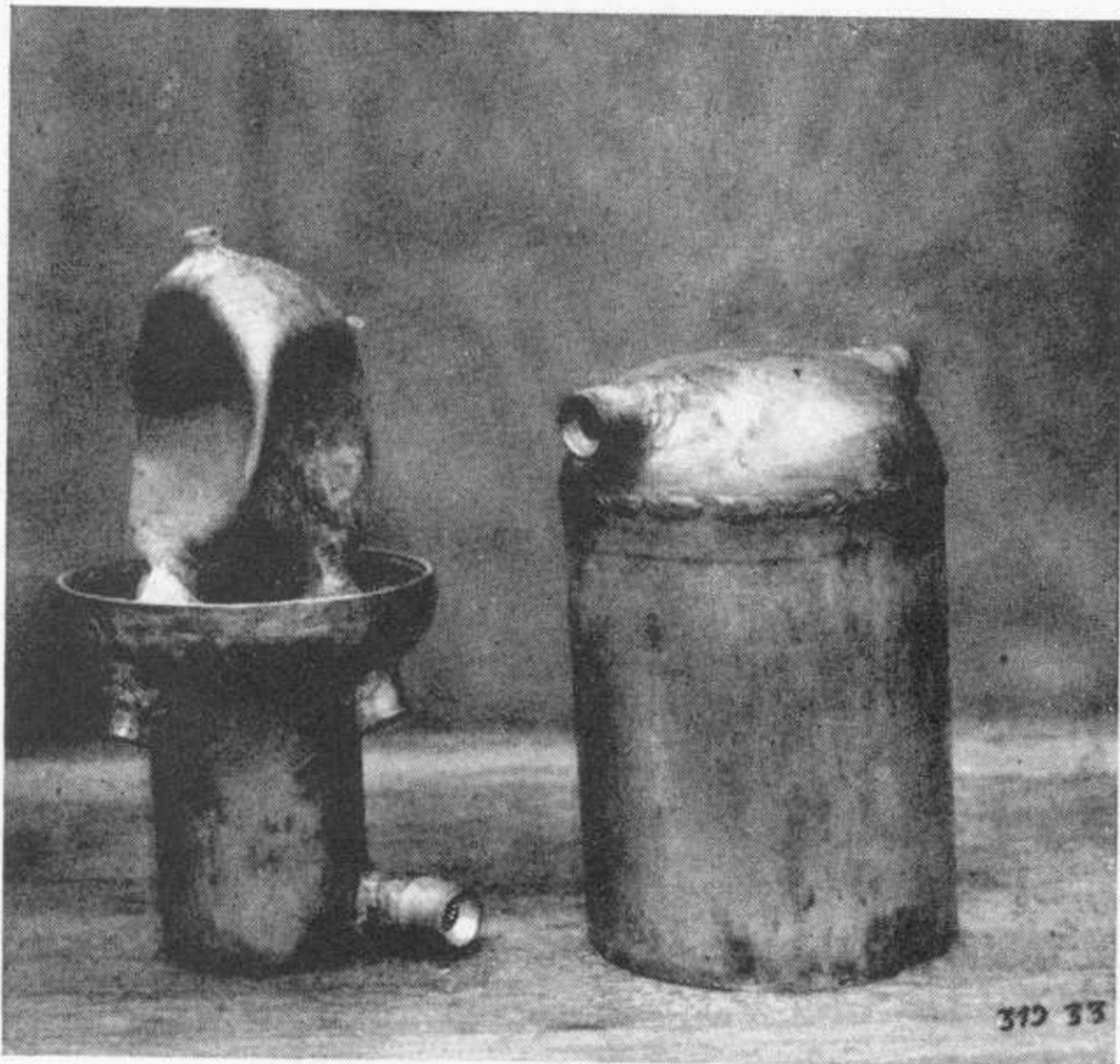
Photo 8: Entwicklung des brennstoffgekühlten Leichtmetallofens: Durch den Kühlwasserdruck eingeknickter Ofen der Type 1 B
